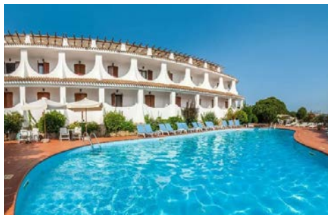
Poolanlage des Hotels Punta Est
