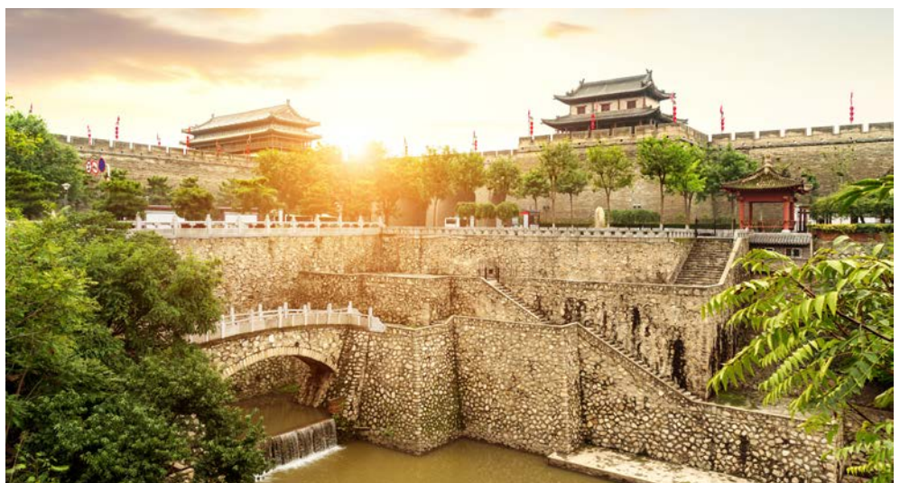
Die Stadtmauern von Xi'an
