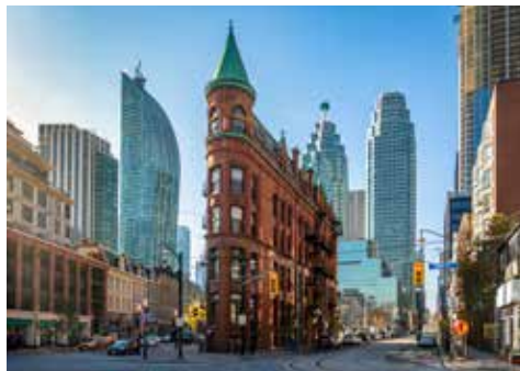
Auch in Toronto gibt es ein Flatiron Building
