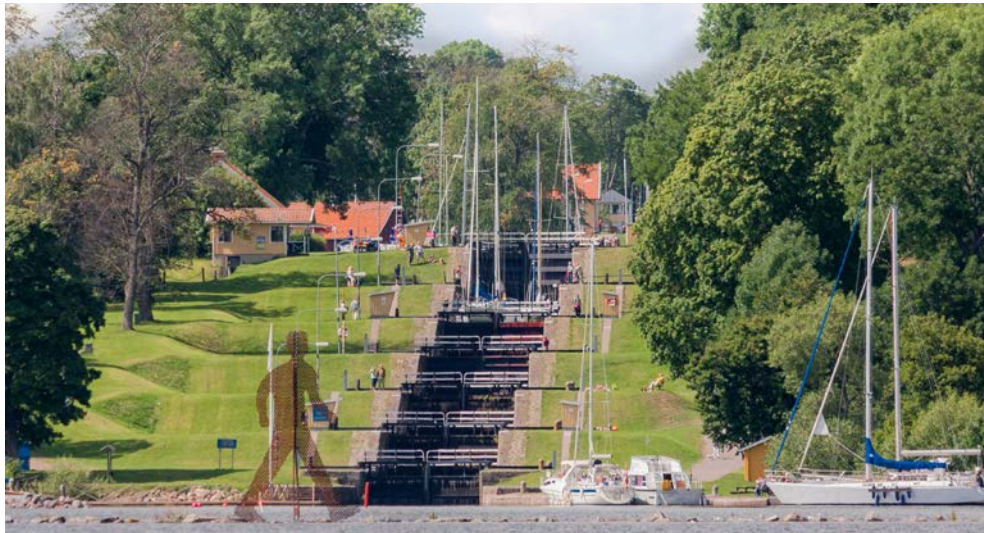
Die Schleusentreppen des Götkanals
