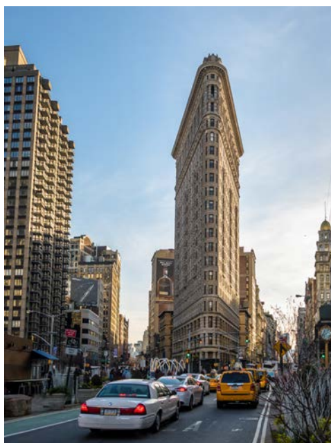
Eine architektonische Ikone – das Flatiron Building
