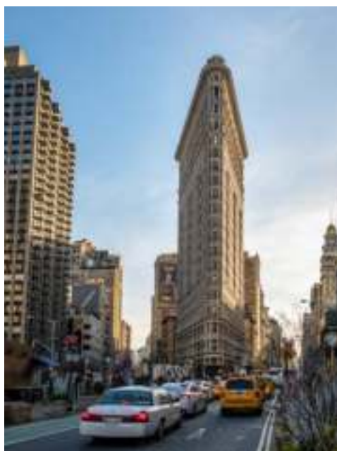
Eine architektonische Ikone – das Flatiron Building
